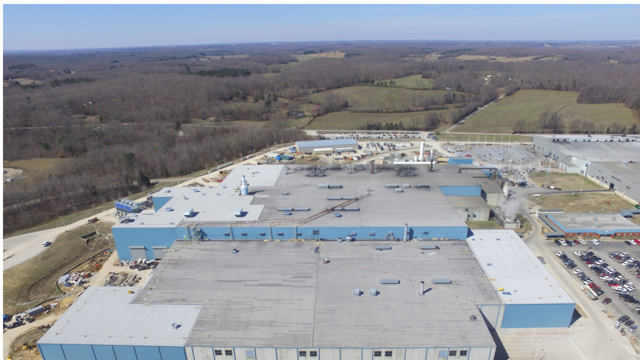
Utbyggnaden av Gränges produktionsanläggning i Huntingdon i Tennessee, USA, fortgår enligt plan.
