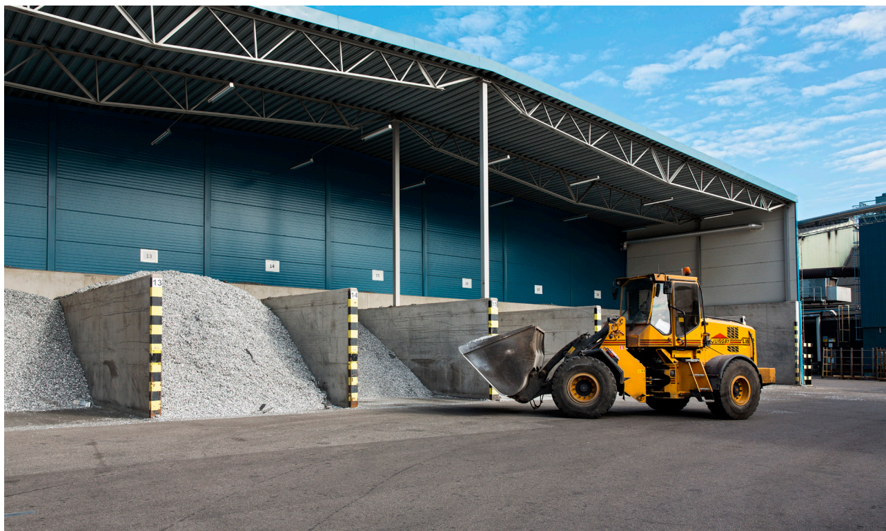
Återvinning vid anläggningen i Finspång, Sverige.
