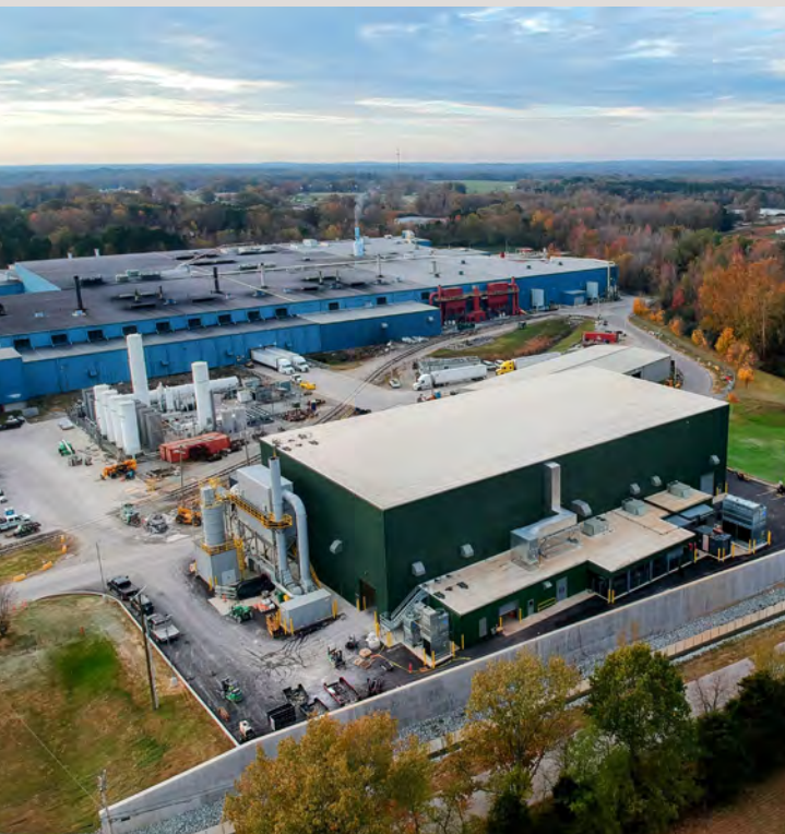
En helelektrisk rännugn som matar en dubbelvalsad gjutningslinje för aluminium.
